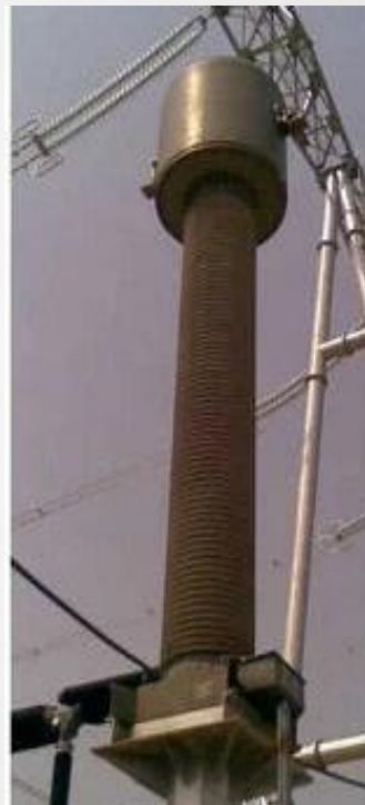
倒立式 ( SF6 ) 电流互感器
